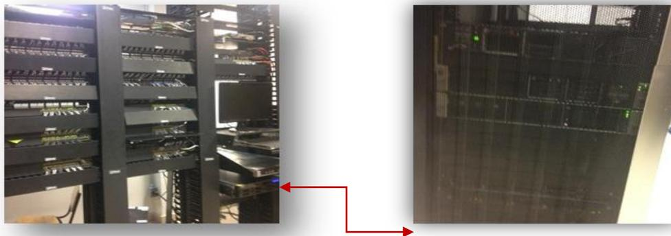
En colaboración con la empresa Sistemas y Enlaces, el pasado 22 de agosto del presente, se realizó la sustitución en el Site del Edificio "B", un Switch marca Cisco Catalys 2960 Plus, que se dañó debido a una descarga de energía eléctrica ocasionada por la caída de un rayo dentro de las instalaciones de la institución, instalándose en su lugar de forma temporal un equipo Cisco (para asegurar la continuidad del servicio), quedando a la espera de que se hagan
